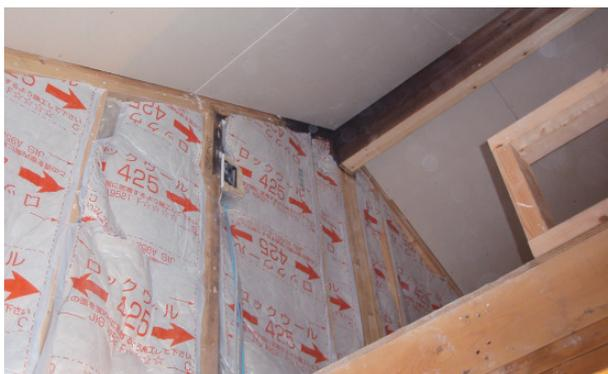
▲火災後、断熱材を施工し直しました。構造躯体には損傷がみられないため、改修工事でそのまま再利用されています。まるで改築の工事現場のようです
